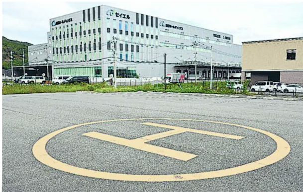
駐車場はドクターヘリや災害時の物資輸送のヘリポートとして使えるようにしている
